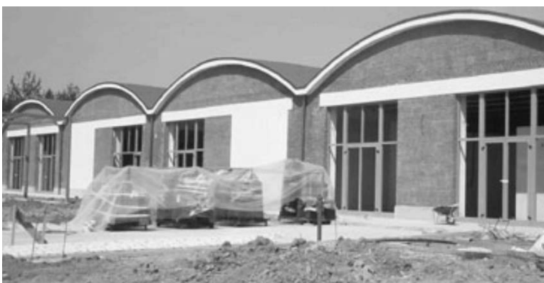
Il cantiere della Città dei bambini
