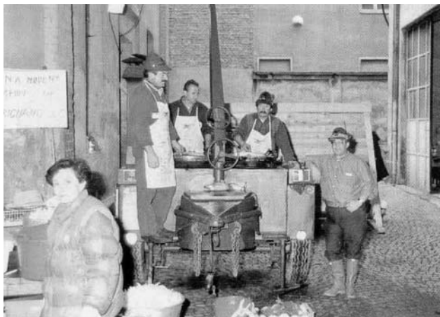
Si prepara il rancio al cantiere
