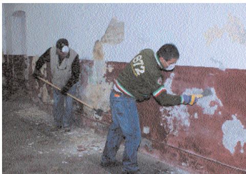
Lavori di sistemazione interni alla Cittadella ad opera di Alpini
